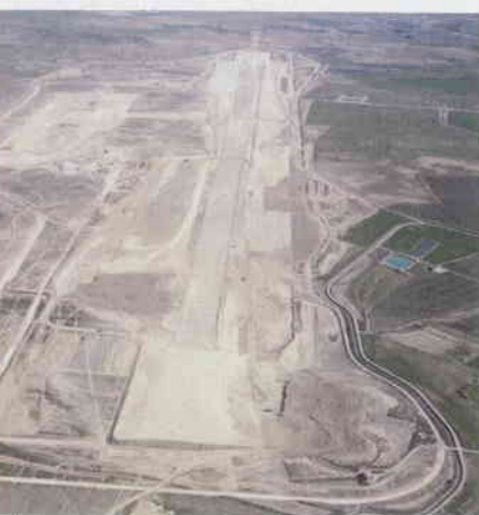
Obres del futur aeroport Lleida - Alguaire
