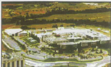
► Centro de producción de RTVE en San Cugat.
