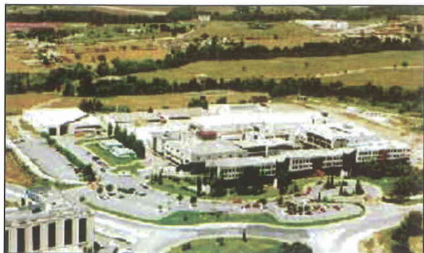
► Centro de TVE en San Cugat.
